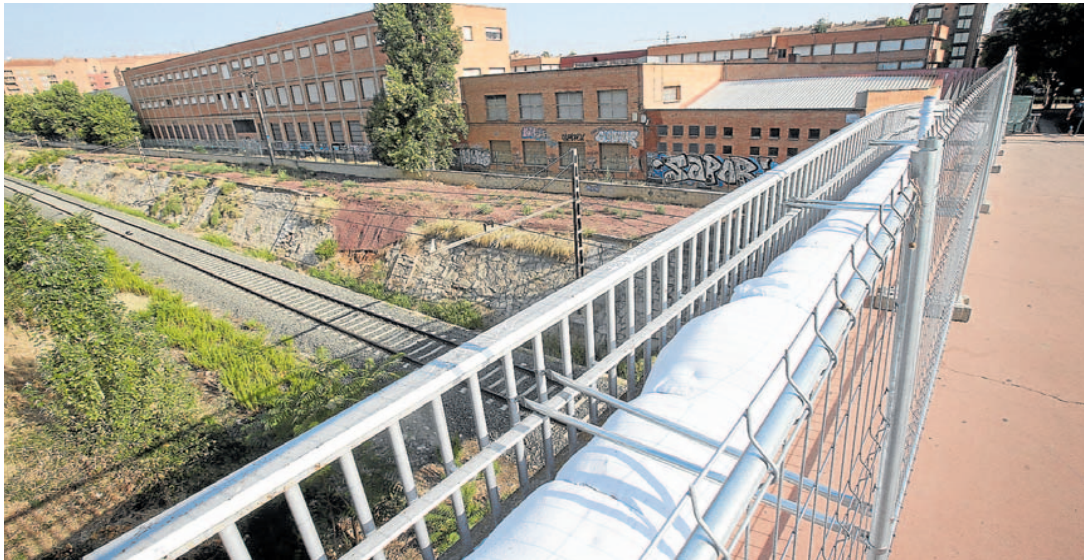
La nueva canalización en la pasarela que une Duques de Nájera y Divino Maestro. JUAN MARÍN
