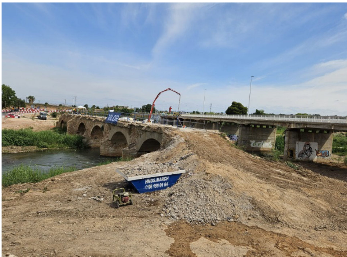
El Gobierno reconstruye once puentes y pasarelas en Valencia con "más capacidad hidráulica y resistencia" tras la dana
