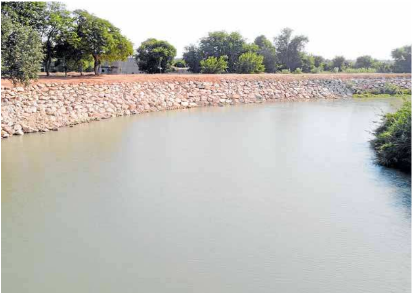
Nuevas escolleras en el río Júcar a su paso por Albalat. LP
